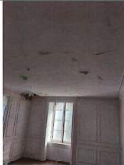
Foto 6: Vista de pintura a base de plomo suelta y desmenuzada (LBP)
