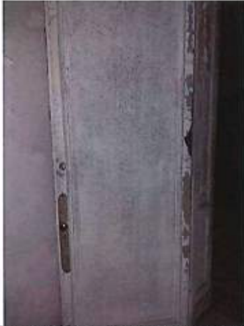
Foto 1: Vista del crecimiento visible de moho dentro del edificio.
