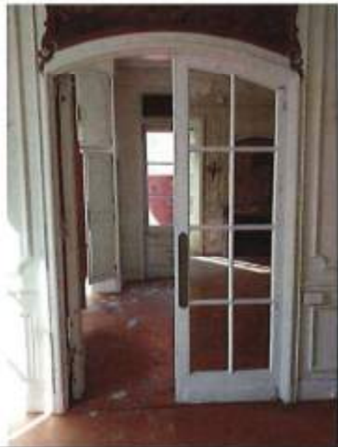
Foto 4: Puerta de madera blanca, jamba de la puerta y marco de la puerta en todo el edificio.
