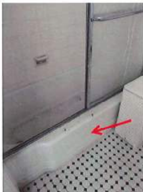
Foto 7: Bañera de cerámica blanca, en todos los baños del edificio.
