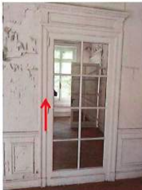
Foto 10: Puerta, jamba y marco de madera blanca (estilo alternativo) en todo el edificio.
