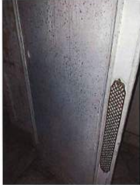
Foto 2: Vista del crecimiento visible de moho dentro del edificio.
