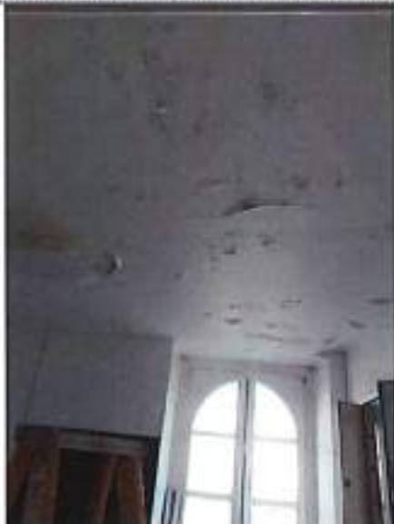
Foto 5: Vista del crecimiento visible de moho dentro del edificio.
