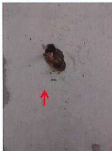
Foto 8: Pared de yeso en todos los edificios.
