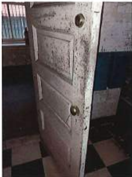
Foto 5: Vista del crecimiento visible de moho dentro del edificio.
